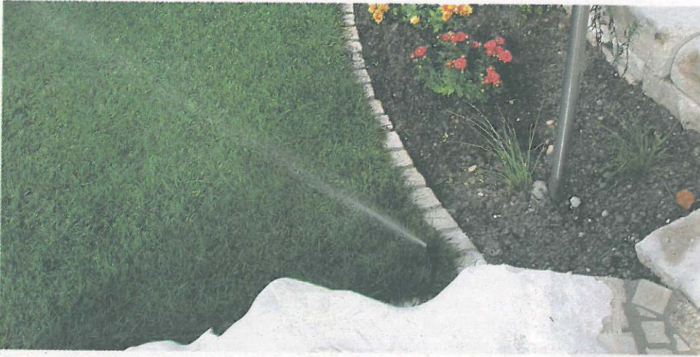
Regner sollten tief genug eingebaut sein, damit sie durch Mäher nicht beschädigt werden.
