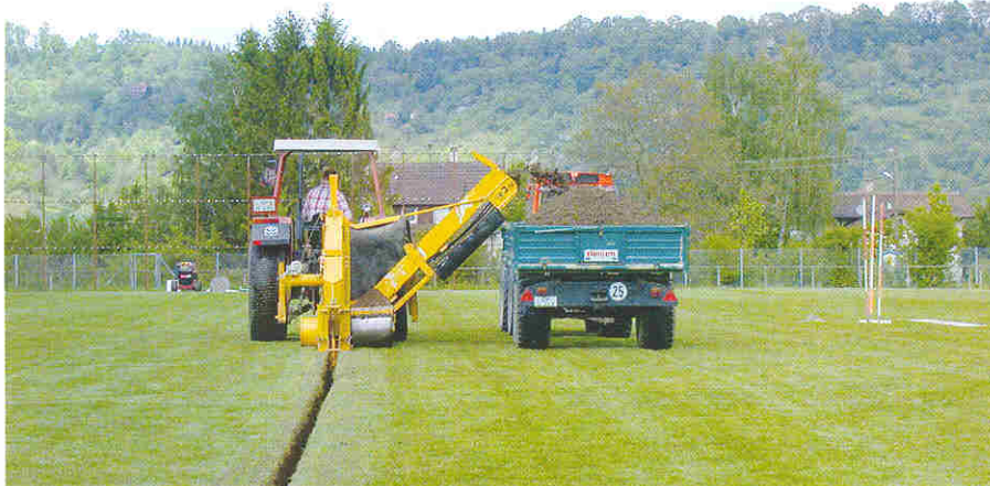
Auch nachträglich ist die Installation einer Bewässerungsanlage ohne größere Schäden möglich. (Fotos: JOINATURE Gartentechnik)
